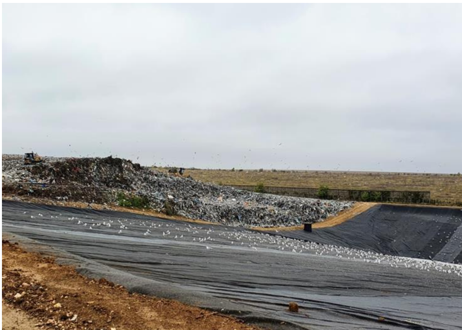
Снимка № 7 Експлоатация на Клетка №1 и изпълнение на строителството на Клетка №2, Регионално депо за неопасни отпадъци, с. Стожер
