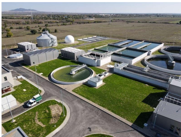
Снимка 1. ПСОВ Ямбол в строеж
