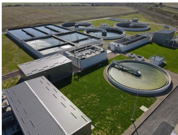
Снимка 2. ПСОВ Ямбол в строеж
