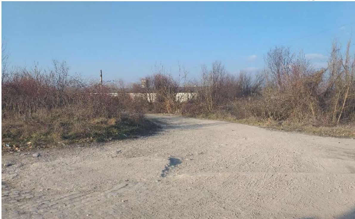
Илюстрация 1 – Бетонов възел в кв. „Калтинец“
