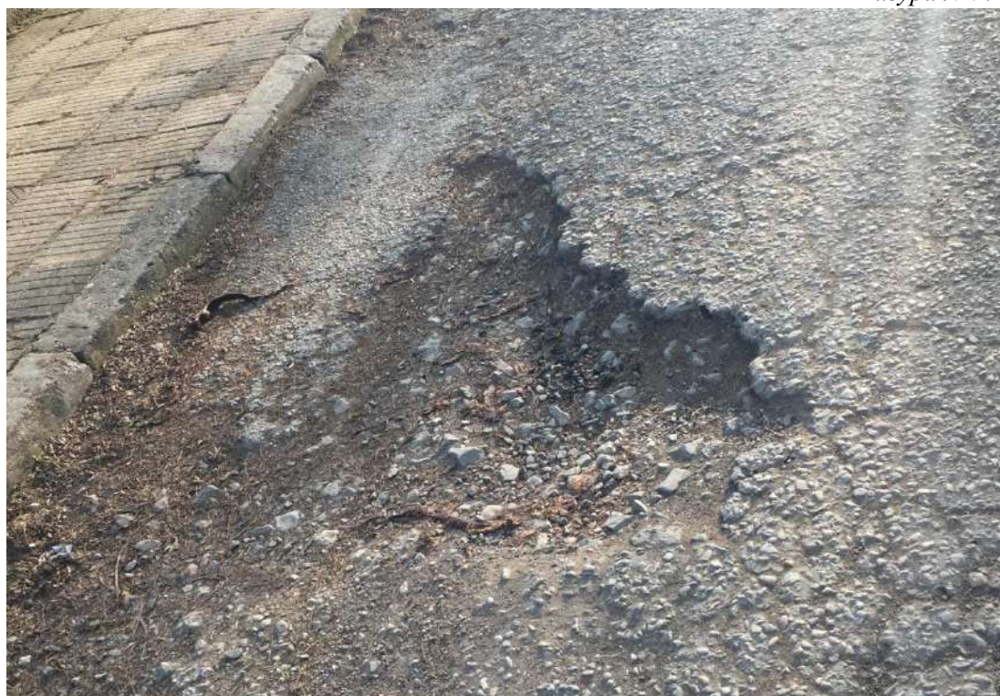
Илюстрация №12 – Състояние на пътни платна, ул. „Възстаническа“
