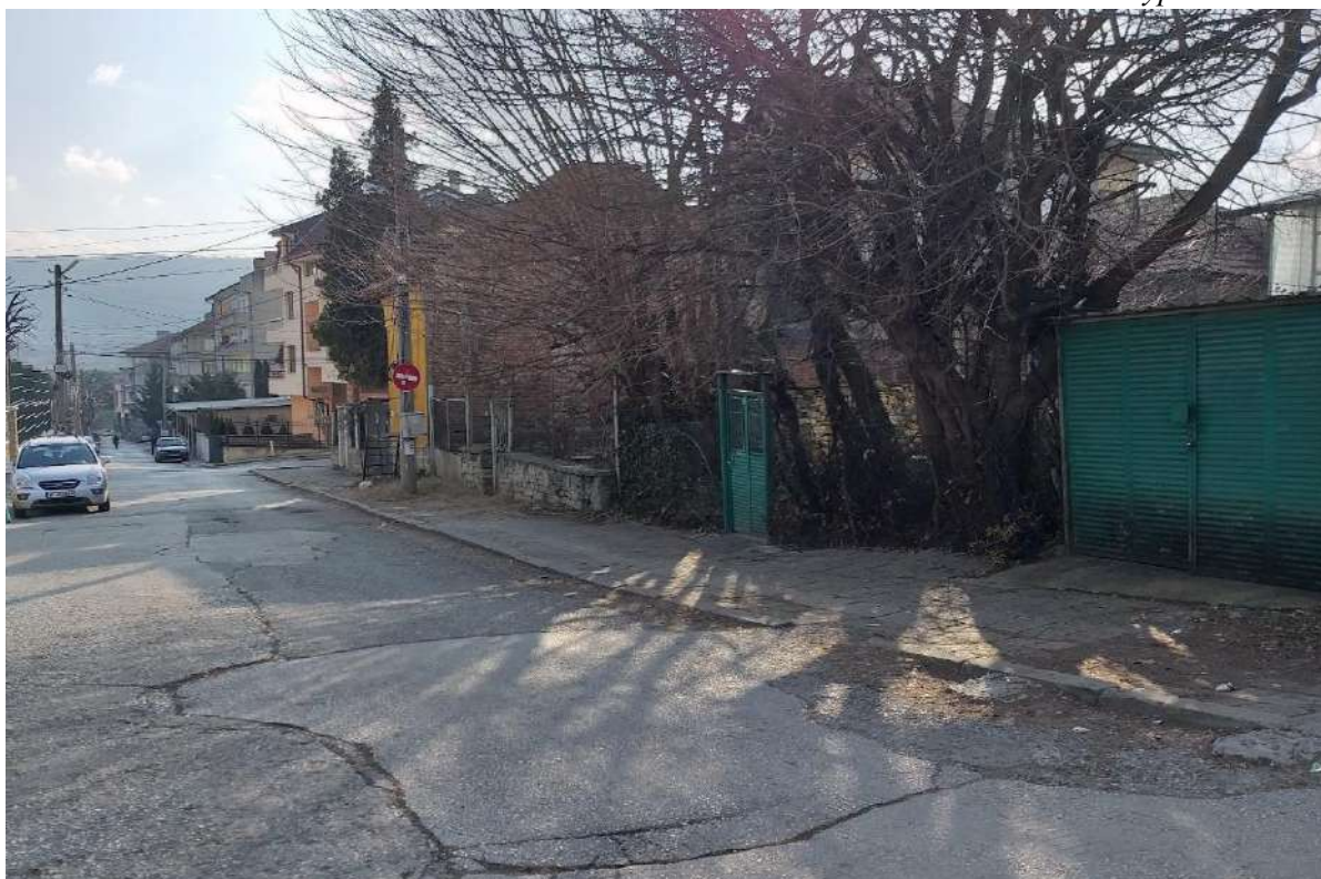
Илюстрация №8– Състояние на тротоарите – ул. „19ти февруари“
